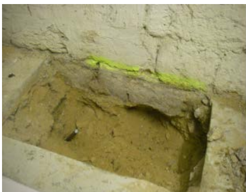
Fig. 14 – Wall fondation
